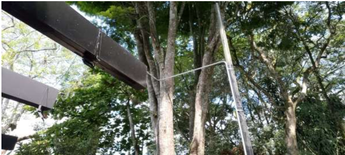
Fotos 12. Suministro e instalación de Ducto IMC 3/4" para alimentar red. Cantidad (24 ml). Ítem no previsto 1 NP01. Fuente: visita C.G.Q.
