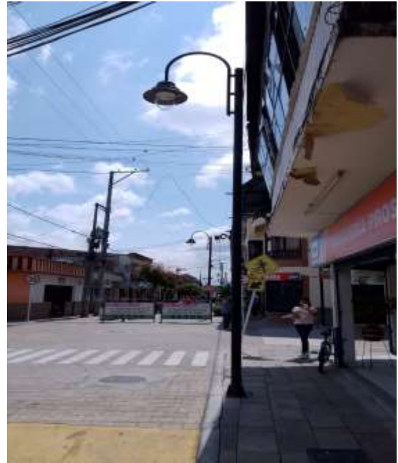
Fotos 10 y 11. Suministro e instalación de Luminaria Albany Led 36W, en Paseo del Edén. Cantidad (1 Und.). Ítem 1,4. Fuente: visita C.G.Q.
