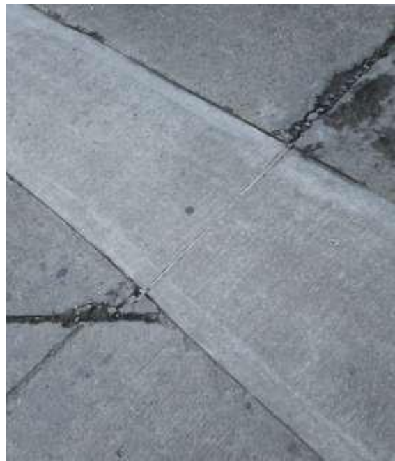
Foto 3. Juntas de dilatación de concreto que no contienen sellado. Foto 4. Junta transversal que sí contiene el sellado. Fuente: Visita técnica C.G.Q.
