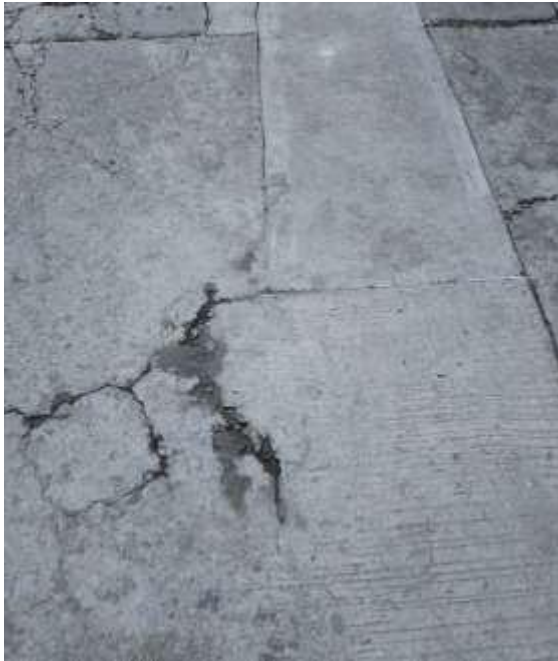
Foto 3. Juntas de dilatación de concreto que no contienen sellado. Foto 4. Junta transversal que sí contiene el sellado. Fuente: Visita técnica C.G.Q.
