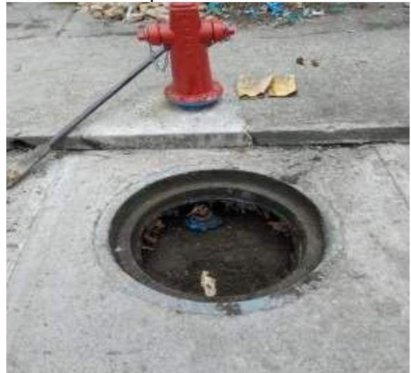
Fotos 1 y 2. Cámaras inicial y final. Se aprecia la tubería instalada. Fuente: Visita técnica C.G.Q.
