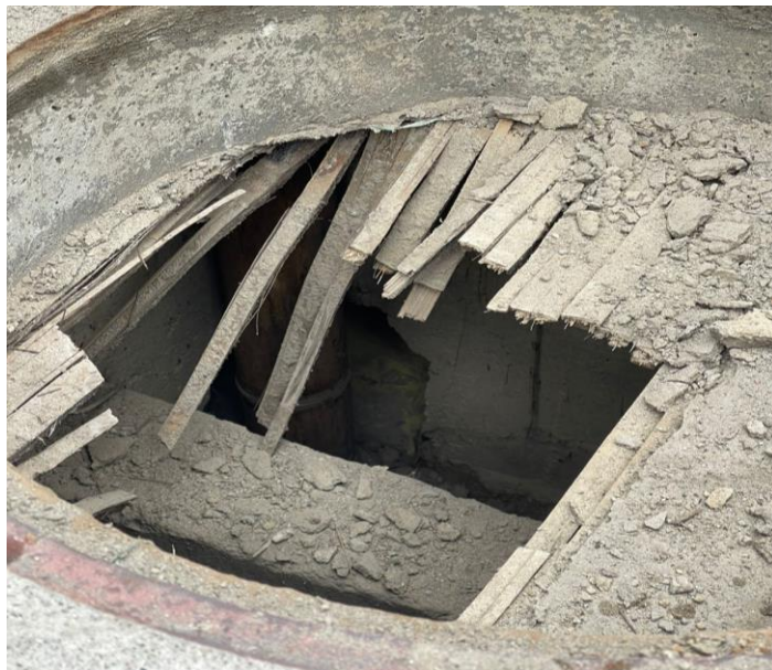
Foto 9. Sumidero al que no se le ha retirado la formaleta de realce. – Fuente: Arq. M. Márquez. Líder del Proceso de Alcantarillado E.P.Q.
