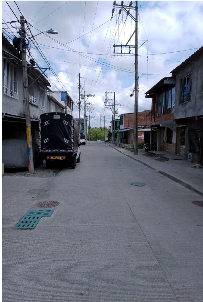
Foto 1. Panorámica de la obra de Pavimentación Barrio Villa Jerusalén Tramo Mz. N. – Fuente: visita técnica C.G.Q.
