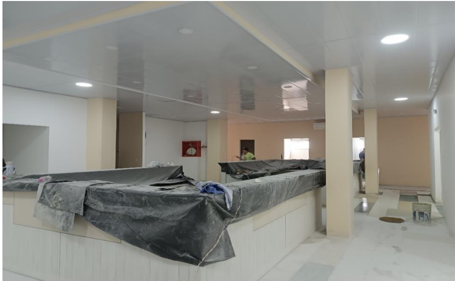
Fotografía No 1: Zona de recepción sin terminar
