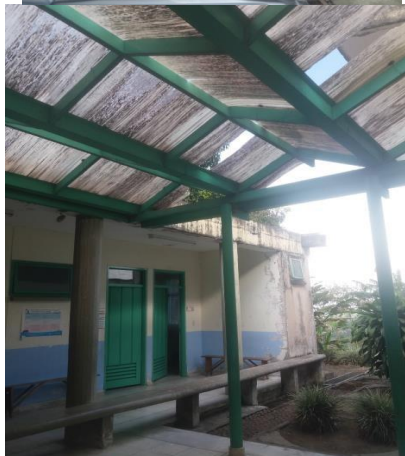
Foto1. Cubiertas Centro de Salud de La Virginia Fuente: CGQ, 2019
