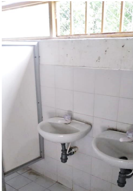
Foto 9. Coliseo Municipal, área de baños – Fuente: visita técnica C.G.Q.
