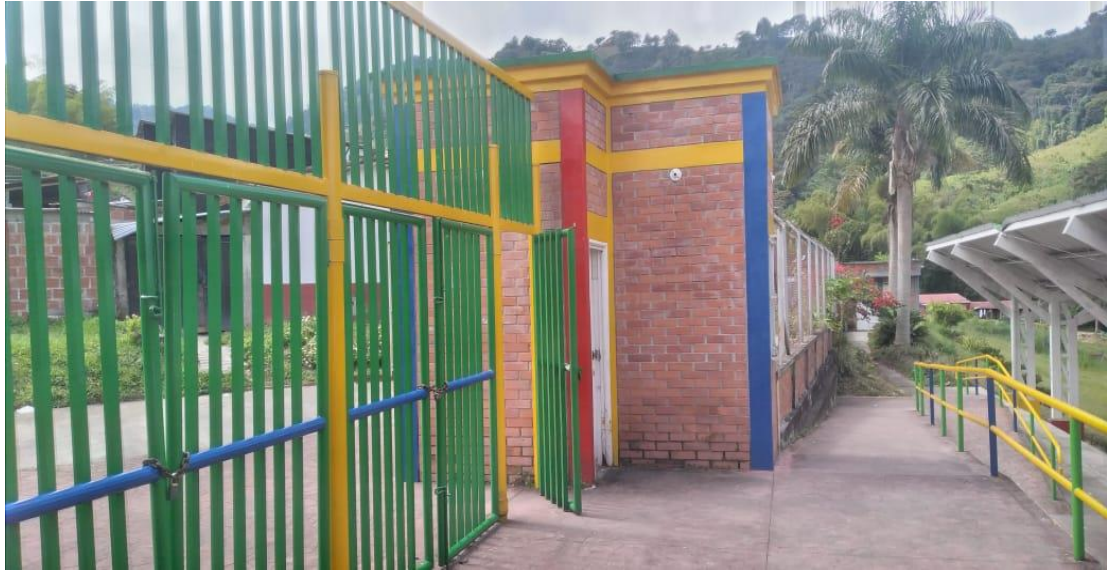
Foto 3. Estadio Municipal, área de acceso al estadio – Fuente: visita técnica C.G.Q.
