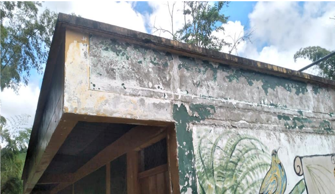
Foto 14. Coliseo Municipal, área lateral de la zona de baños – Fuente: visita técnica C.G.Q.
