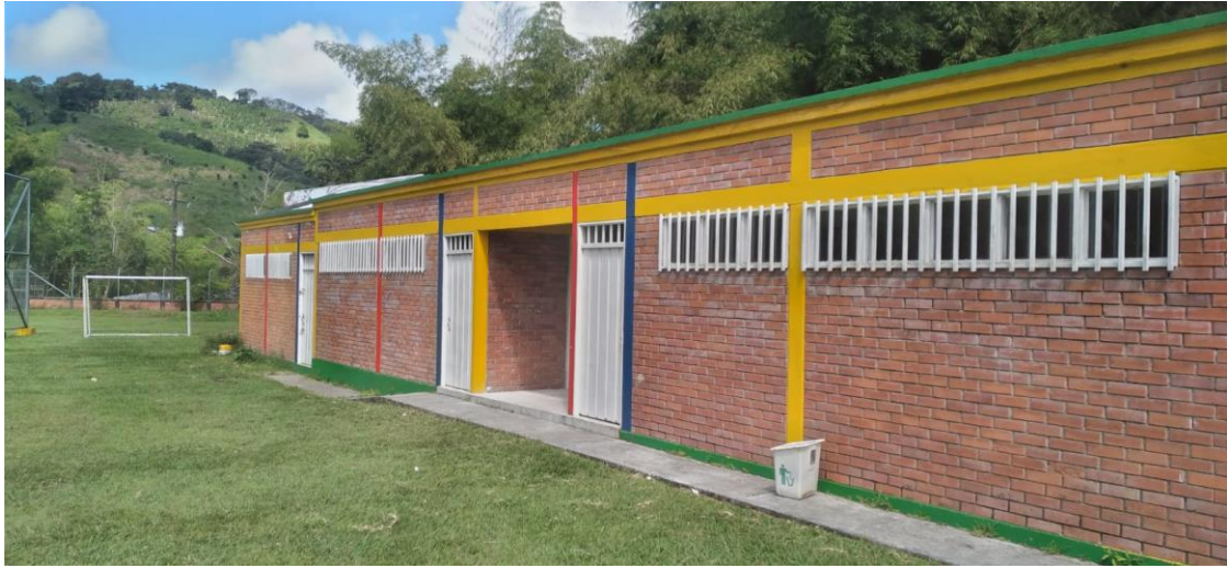
Foto 7. Estadio Municipal, Estructura de camerinos y baños – Fuente: visita técnica C.G.Q.
