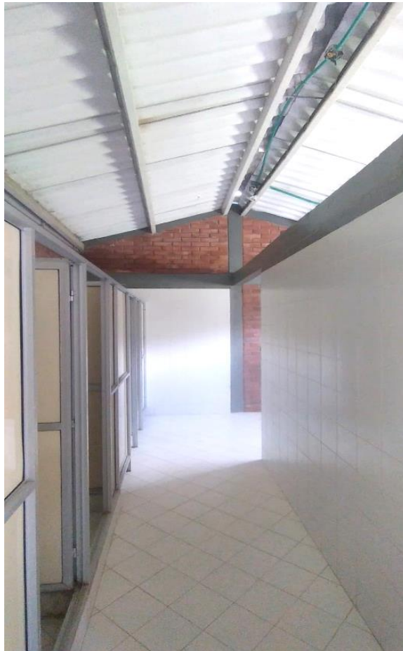
Foto 8. Estadio Municipal, área de baños – Fuente: visita técnica C.G.Q.
