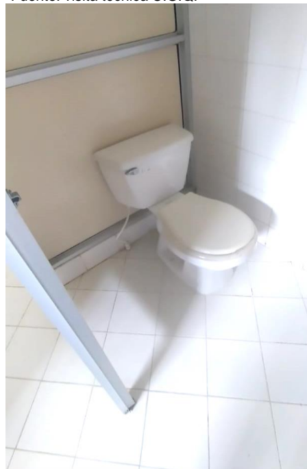
Foto 10. Coliseo Municipal, área de baños – Fuente: visita técnica C.G.Q.
