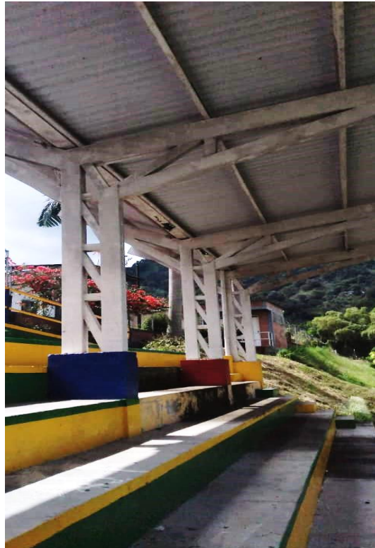
Foto 4. Estadio Municipal, área de graderías vista lateral – Fuente: visita técnica C.G.Q.
