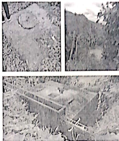
Fotos 43, 44 y 45. Estructuras del Sistema de tratamiento de aguas residuales de Filandia- El matadero
